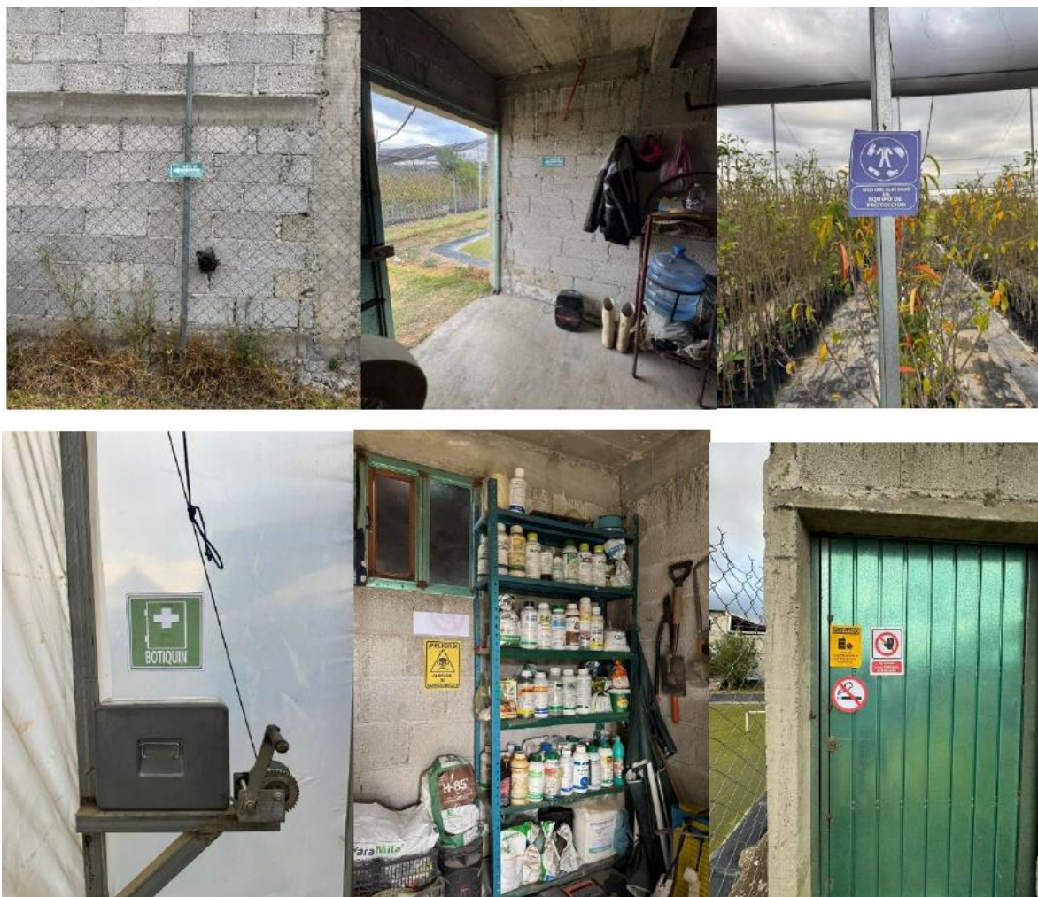
Figura 1. Instalación de señalética
